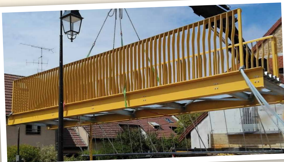
↑ Remplacement de la passerelle du Tamiset.
