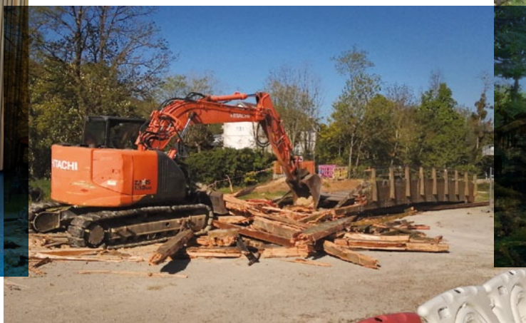
23 avril 2025 : démantèlement de l'ancienne passerelle en bois.
